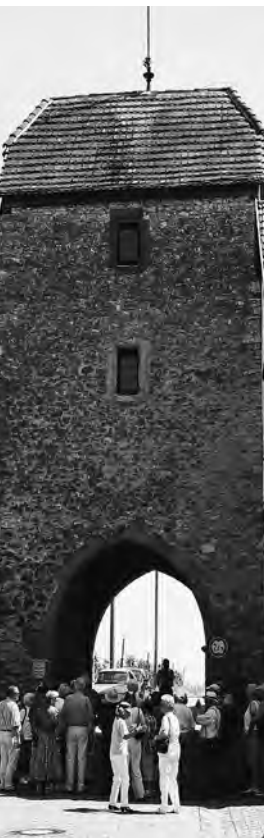
Die Kommende war von einer Mauer umgeben – ein Torturm ist in Originalzustand erhalten. Foto: Ulrich Unger
